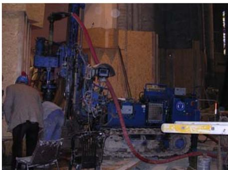
*Figure 10 : Foreuse automotrice*
