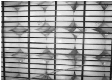
*Figure 5 : Structure permettant un positionnement efficace des nodules dans le ballon [4]*
