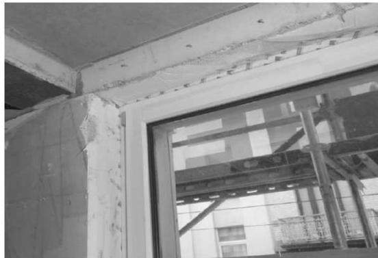
*Figure 10 : Méthode d'application du plafonnage sur la membrane CONTEGA [14]*
