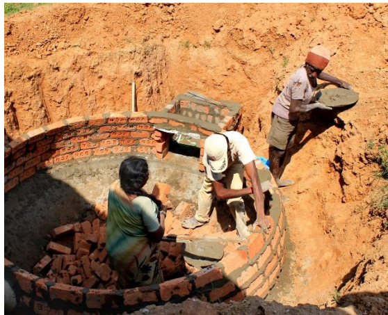
Figure 1 : Construction d'un digesteur à dôme fixe
