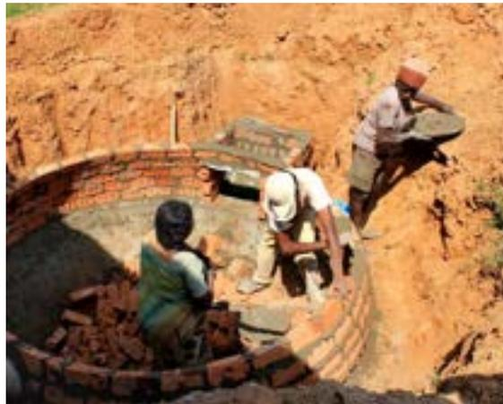
*Figure 1 : Construction d'un digesteur à dôme fixe*
